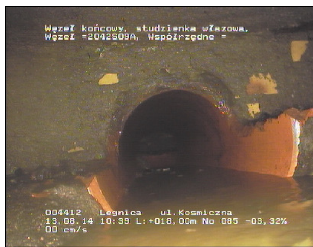
Foto 085 Wideo: CD1 Stan BCE A 18,00 m Węzeł końcowy, studzienka wiazowa
