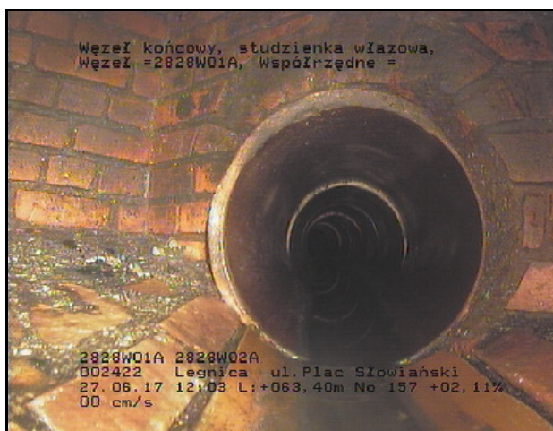
Foto 157 Video: CD1 Stan BCE A 63,40 m Węzeł końcowy, studzienka wiazowa
